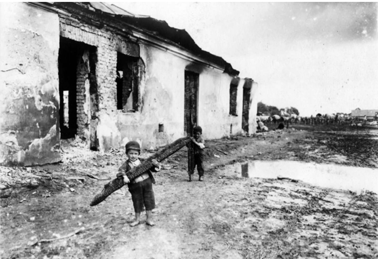
Zerstörte, abgebrannte Häuser in Leczna bei Lublin, Russisch Polen
